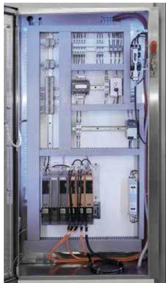
图3 系统减少了控制柜数量，只保留一个控制柜，减少了元件的成本，缩小了体积，布线也更加清晰。
