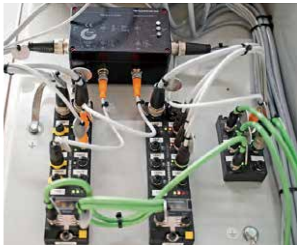
该安全应用由TBP（左）控制，用于工厂中的测试。Profisafe控制器则在最终客户侧接管应用的实际运行。所有连接至IO-Link master（中）的执行器都通过TBSBox进行安全关断
